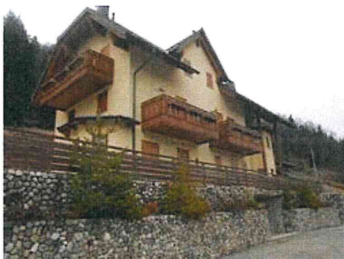
Vista del fabbricato
