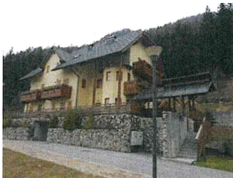
Vista del fabbricato
